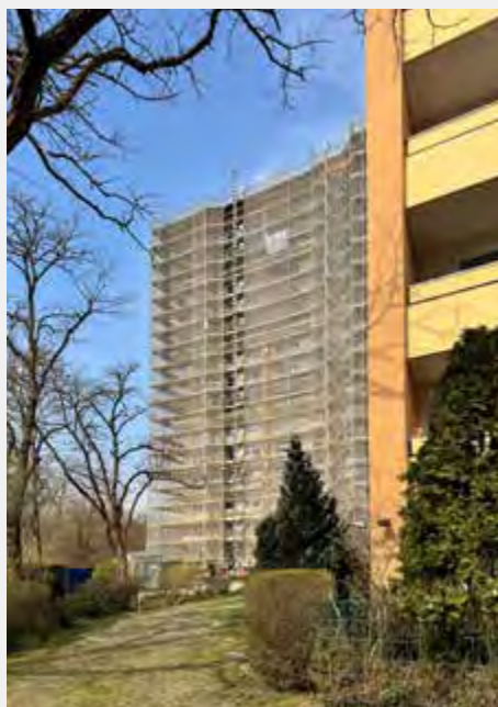
Im Lichterfelder Ring 105–109A wird ein Konzept mit neuen Vorstellbalkonen geprüft. Im Hintergrund das Gebäude Lichterfeld Ring 111 mit der noch eingerüsteten Fassade.
