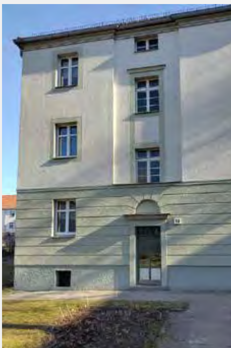
In der Joachimstraße werden die Fenster erneuert.
