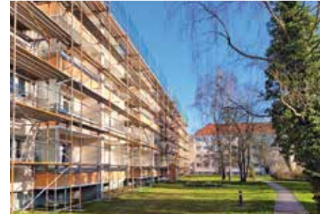
Bei der Dachsanierung in Lankwitz kam erstmalig eine innovative Oberlagbahn zum Einsatz, die aufgrund ihrer Beschichtung mit einer photokatalytischen Wirkung schädliche Stickoxide aus der Luft aufnimmt und umwandelt.
