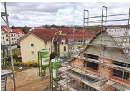
Nach Fertigstellung der neuen Häuser entsteht ein harmonisches Bauensemble mit den Gebäuden von 1997 (Mitte) und 2019 (hinten).
