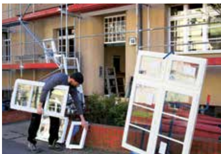
In enger Abstimmung mit dem Denkmalschutz wird die Fenstererneuerung in Schmargendorf fortgesetzt. In einem patentierten Verfahren werden nach dem einzelnen Ausmessen aller Fenster neue Außenelemente mit der gleichen Profilierung, Sprosseneinteilung und sonstiger Merkmale anfertigt.
