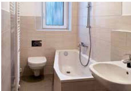
Bad mit neuen Sanitärelementen nach der Strangsanierung im Wedding.
