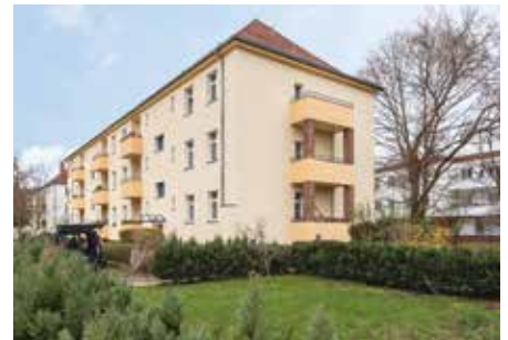
Die Gebäude in der Köpenicker Annenallee 10 – 11b nach der Fassaden- und Fenstersanierung
