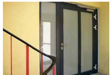
Mehr Sicherheit durch neue Brand- und Rauchschutztüren im Tirschenreuther Ring 70 und 72
