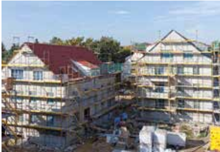
Rascher Baufortschritt: der Neubau in Schöneiche im Sommer 2018
